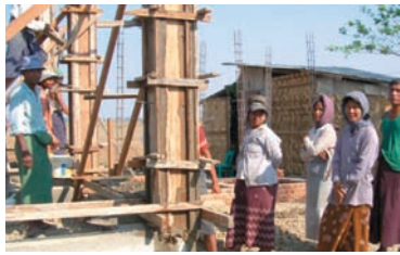
▲建設中のティダーミヤインクリニク
