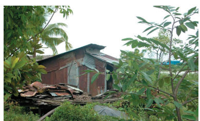
▲応急に建てたクリニック。側のトタン板は壊れた時のままのもの。
