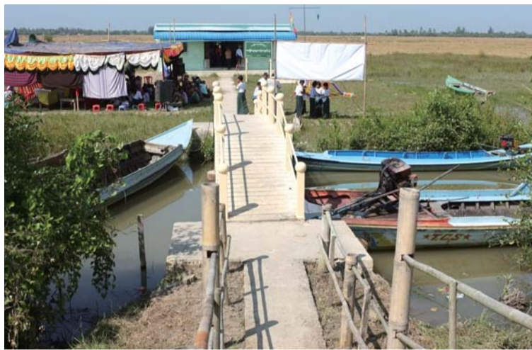
架け替えられた鉄筋コンクリート造りの「北村橋」。向こうが小学校
